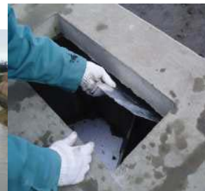
底板プレート設置状況
