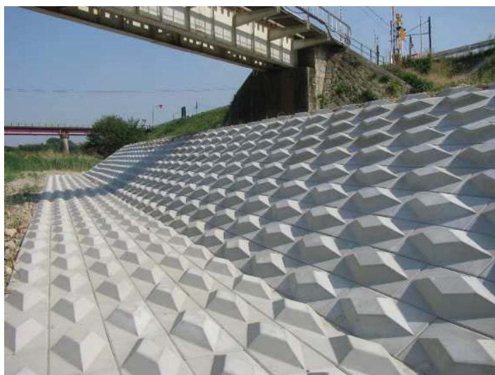
ダイヤカット施工写真
