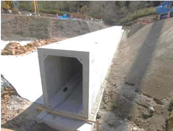
ボックスカルバート 施工状況
