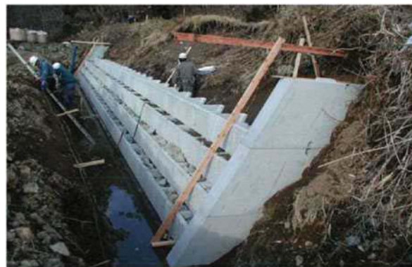
ブロック積みに合わせて設置する
