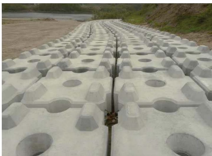
リーフロック施工写真
