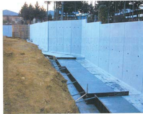
施工状況（底版部現場打ち）
