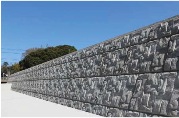
KPブロック施工写真
