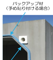
充填前 高弾性接着剤の充填部 (内目地)
