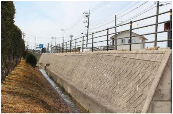
安定スプリット施工写真
