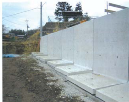
敷き段差施工
