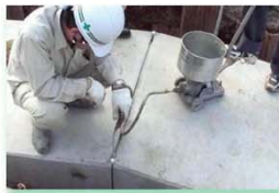
頂版から注入
